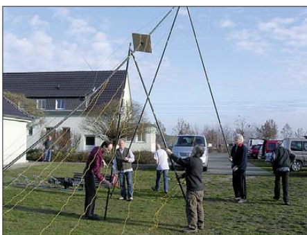
Gemeinsame Anstrengungen bei der Groundplane-Aufstellung Fotos: DL2FI
